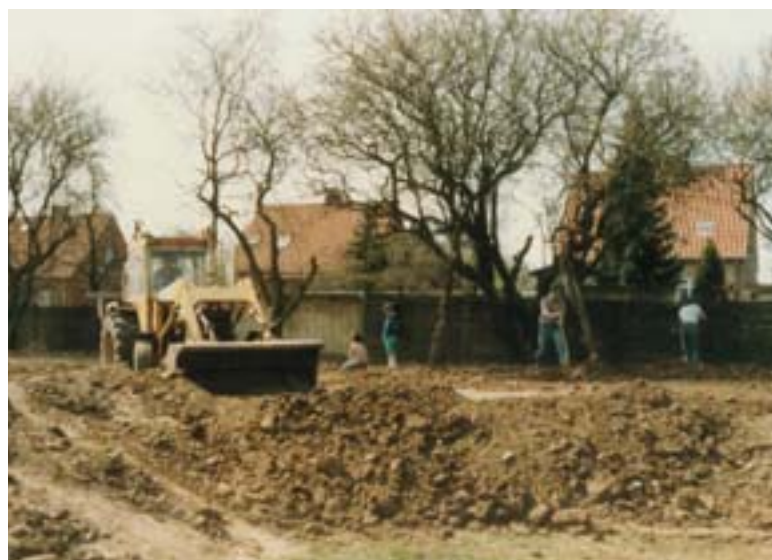
Forældre anlægger den nye sportsplads.
